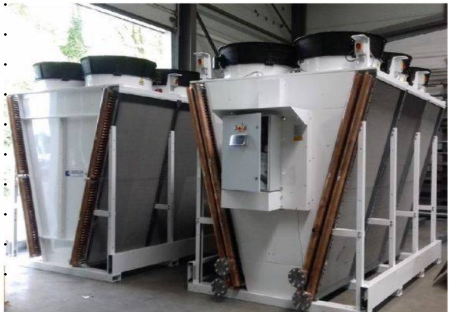
Fig 2 : système de refroidissement moderne conforme au 42e BlmSchV (Source : Foundry Service GmbH)
