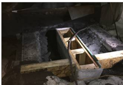
Illustration d'un re-chemisage du séparateur laitier.
