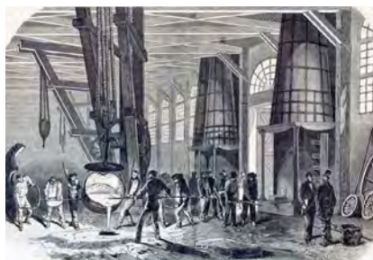
Fig. 17a - La fonderie de l'Usine de Grenelle (L'illustration - association C.A.I.L.).
