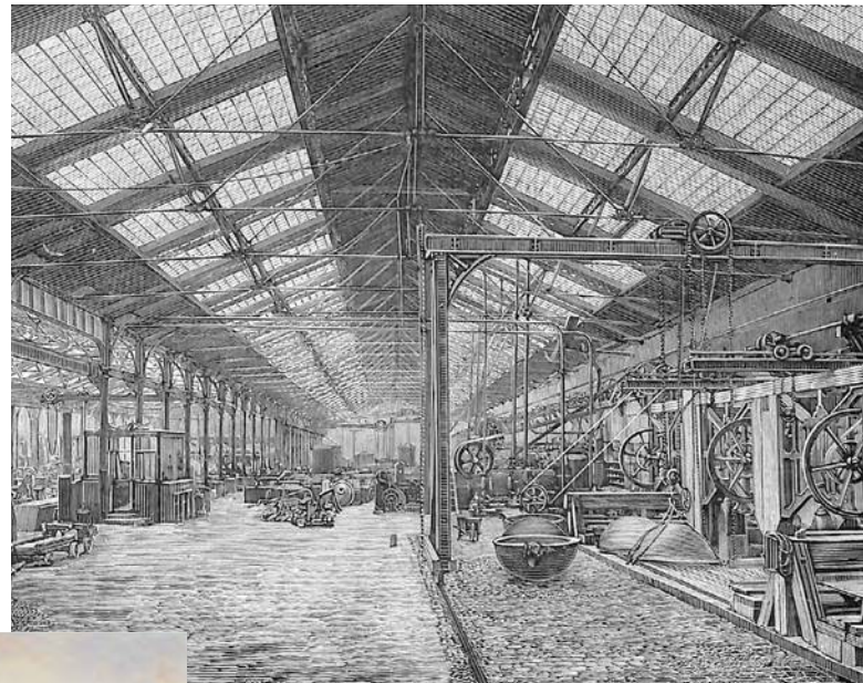
Fig. 17d - Atelier de chaudronnerie cuivre de l'usine de Grenelle.
