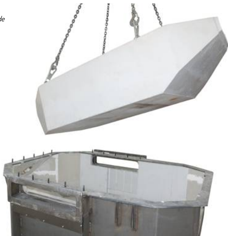
Mise en place du bloc bassin
