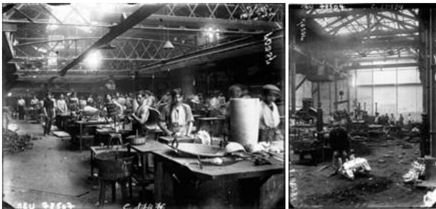
Cie Parisienne de Choisy-le-Roi. Fonderie d'aluminium. Les ateliers de moulage en coquille et au sable
