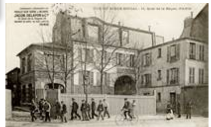
Jacob, Delafon & C ie - Vue du Siège Social au 14, Quai de la Rapée, Paris
