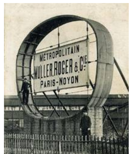
Métropolitain de Paris. Ligne n°8. Passage sous la Seine au Pont Mirabeau. Vue d'un anneau en fonte - Fragment du tunnel (photo source Inventaire général du patrimoine culturel en Picardie.) https://inventaire.hautsdefrance.fr/
