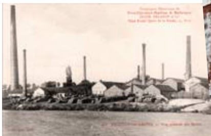
Vue générale des Usines Jacob, Delafon & Cie à Pouilly-sur-Saône et Belvoje (1905)
