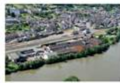
Deville Usine Saint-Eloi en bord de Meuse
