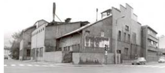
Etablissements Pierre Collignon S.A. Avenue Aristide Briand 38-Fontaines BP 16 en 1975
