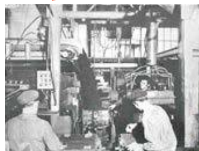
Chantier de moulage semi-automatique - © GH-FML
