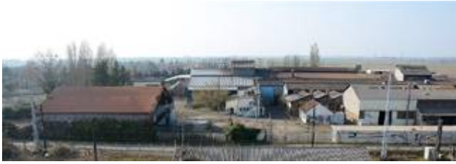
La Fonderie de Meung-sur-Loire en 2013 (avec un bâtiment incendié) - © Joël Aubry
