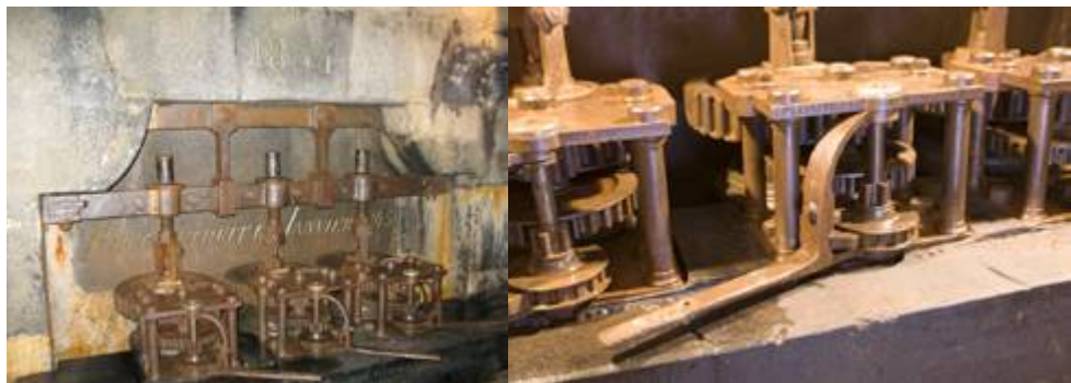
Robinet d'ouverture de vannes dits les « robinets de Saint-Ferréol »
