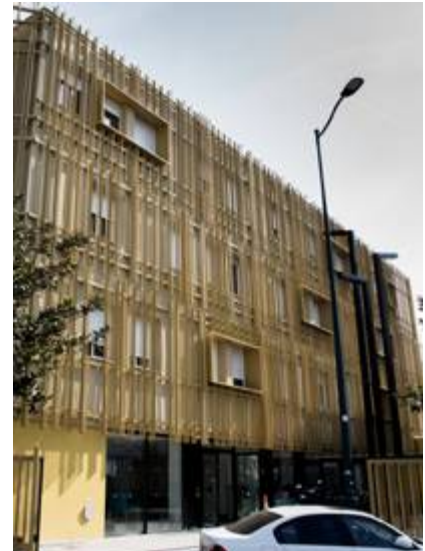
Maisons des Compagnons du Devoir de Pantin (93) © T. Caron/Divergence
