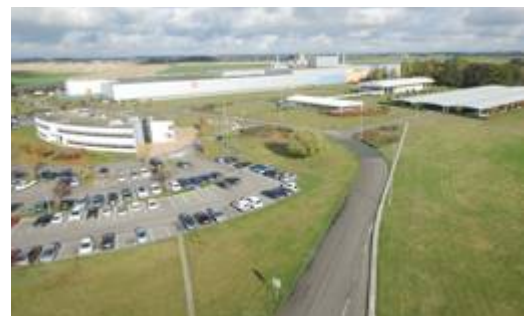
Vue aérienne de la fonderie Picardie, à Saint-Crépin-Ibouvillers (Oise)
