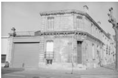
Usine de matériel d'équipement industriel William Gillet. Premier atelier de fabrication à gauche et premier logement patronal. Crédit : Région Nouvelle-Aquitaine, Inventaire général du patrimoine culturel, Kabouche Marie
