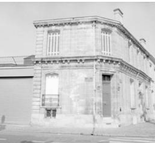
Usine de matériel d'équipement industriel William Gillet. Premier atelier de fabrication à gauche et premier logement patronal. Crédit : Région Nouvelle-Aquitaine, Inventaire général du patrimoine culturel, Kabouche Marie
