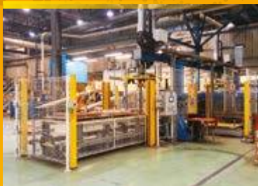
Unité de pose de noyaux
