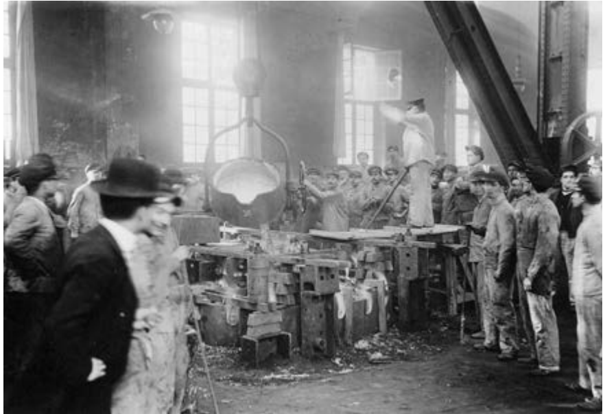
18 juin 1912 - Ecole d'Arts et Métiers d'Aix-en-Provence - Coulée du moule de la vasque de la place d'Albertas Photographie Henry ELY, Aix
