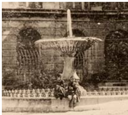
La fontaine avant 1912 – La dégradation de la pierre de la vasque est visible à droite.
