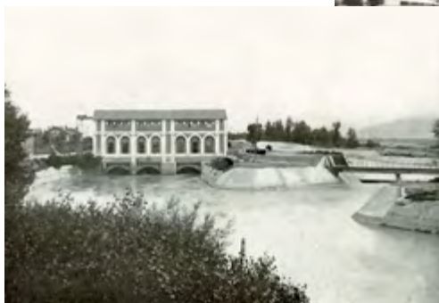
Usine de Le Lague mise en service en 1916 3 x 3 000 CV Turbines Francis - Hauteur de chute : 9 m, débit : 80 m³/s
