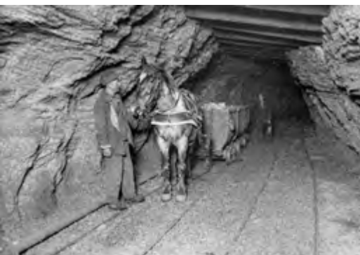
Tractage des wagonnets dans les galeries par les chevaux.
