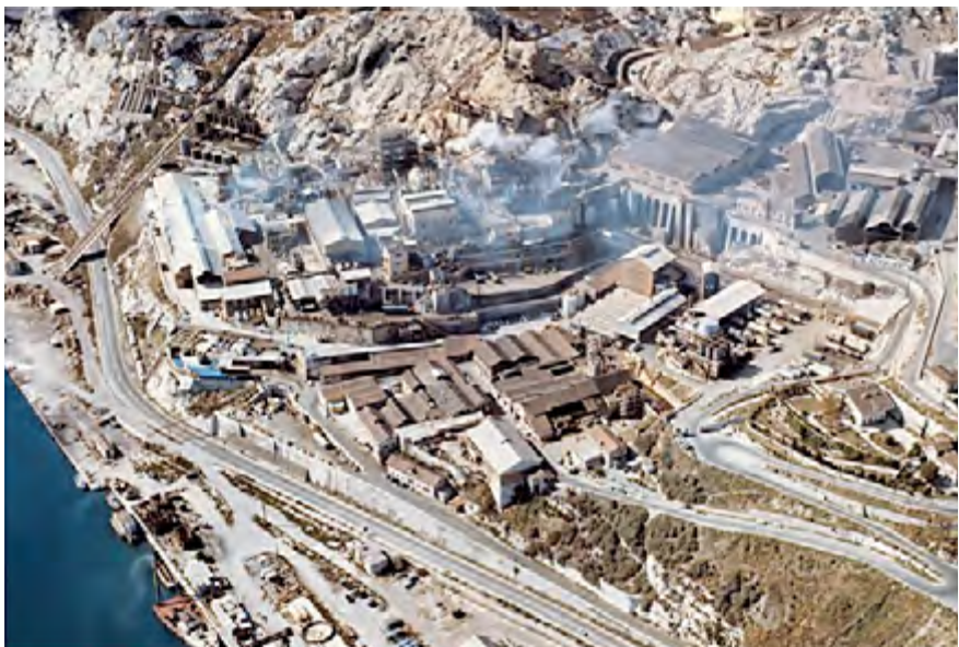
Vue aérienne du site Kuhlmann de l'Estaque accueillant l'usine ATEX
