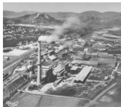
Vue aérienne de l'usine après 1953
