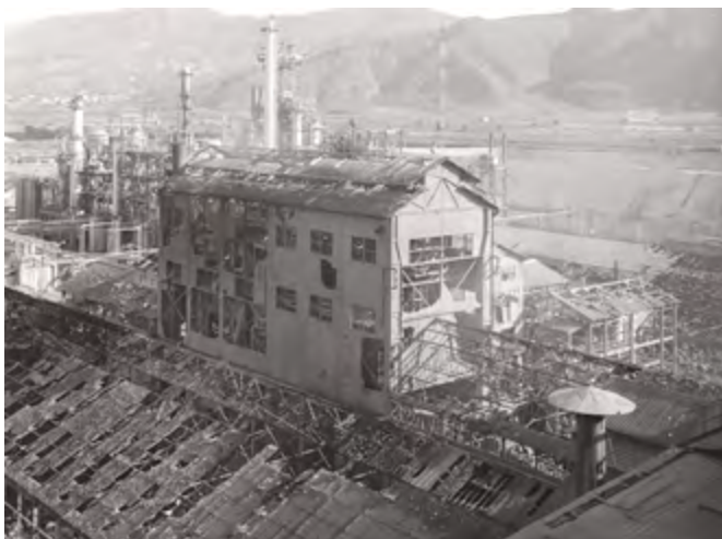
16 novembre 1970, les bâtiments après l'incendie et les explosions
