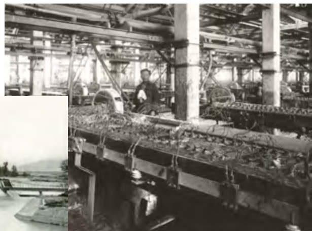
1938, l'atelier chlore et ses 144 bacs - Source : Archives de l'usine
