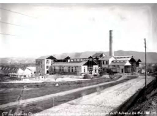
Construction de l'unité d'alumine à Saint-Auban - Prise de vue le 24 mai 1916
