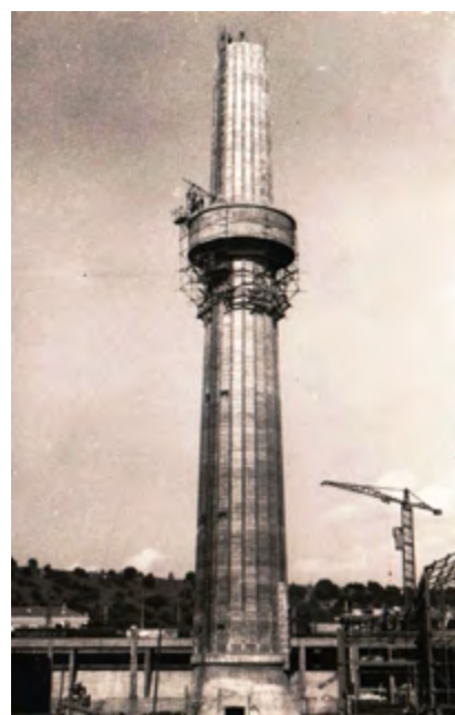
Construction de la cheminée du carbure en avril 1952
