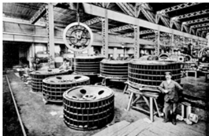
(BG) Une turbine pour les hautes chutes. (BD) Montage des turbines pour basses chutes et gros débit.
