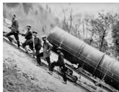
Installation de la conduite forcée.
