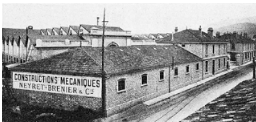
(G) Les ateliers de construction de machines Neyret-Brenier & Cie. (D) Le grand tour parallèle : hauteur de pointe 1,6 m - longueur entre pointes 5 m.
