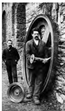
Turbine en fonte à sept branches d'un diamètre de 2,4 m avec son injecteur interne centrifuge © Maison Bergès à Lancey.
