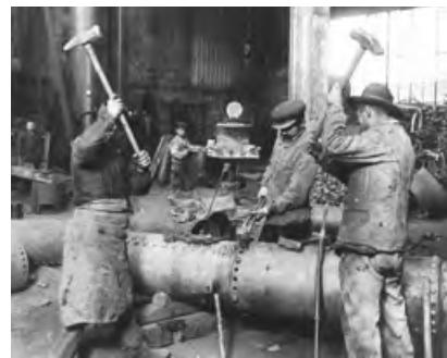
Lancey, rivetage des conduites.
