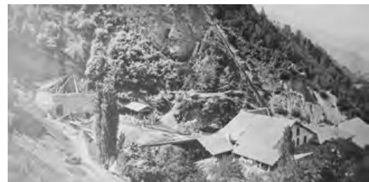
Râperie de Lancey vers 1873. En arrière-plan la conduite forcée de 200 mètres qui alimente l'usine • Source : Musée de la Houille Blanche Maison Bergès à Lancey.
