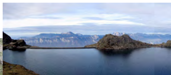
Le lac Crozet et son barrage sur fond du Massif de la Chartreuse. Source : © Photo Pierre Combaz
